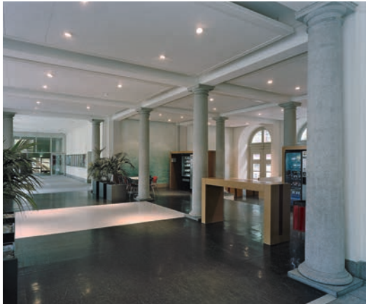
Korridor und Halle vorher und nachher
